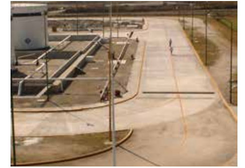
PAVIMENTOS DE CONCRETO EN DIVERSAS ESTACIONES DE COMBUSTIBLE ASA
