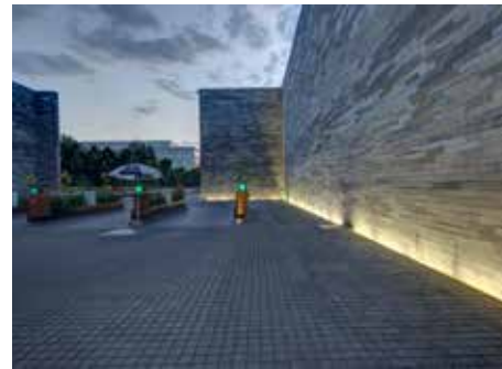
OBRAS EXTERIORES EMPRESALIA QUERÉTARO
