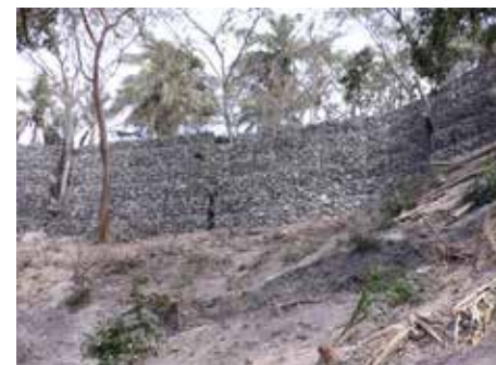
CONSTRUCCIÓN DE MURO A BASE DE GAVIONES
