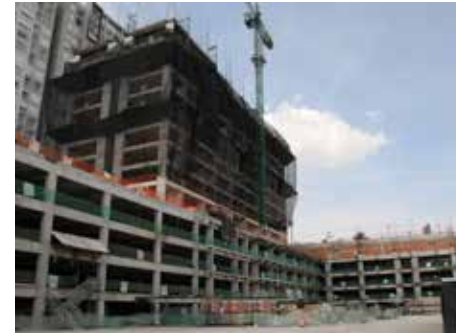
RESIDENCIAL SAN ÁNGEL CASA CLUB Y VIVIENDA
