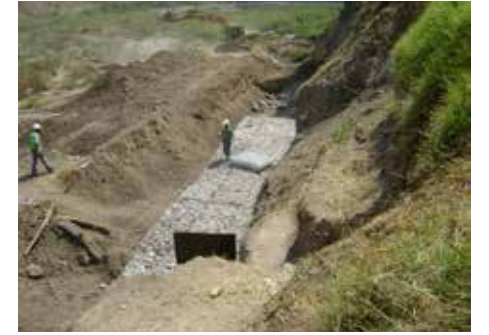
OBRAS DE EMERGENCIA EN DIVERSOS RÍOS PARA CONAGUA
