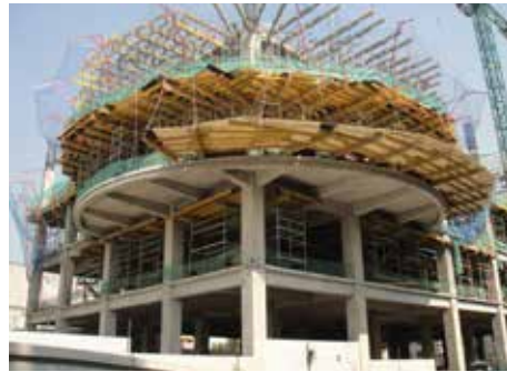
EDIFICIO PARA HOSPITAL SAN ANGEL INN MITIK
