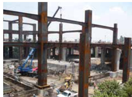
OBRAS DE CONCRETO ESTACIÓN DE TREN LIGERO Y CENTRO COMERCIAL BUENAVISTA
