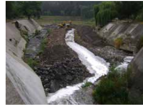
OBRAS DE EMERGENCIA EN DIVERSOS RÍOS PARA CONAGUA
